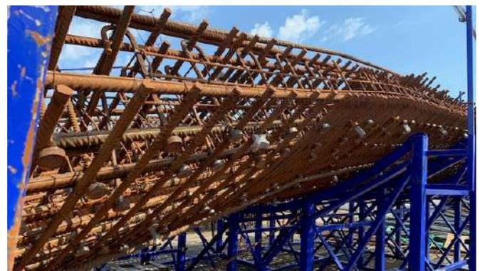
Арматурные стержни с головками устанавливаются во время укрупнительной сборки стеновых панелей.
