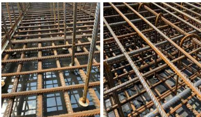
Применение арматурных стержней с головками позволяет уменьшить избыточность арматуры и повысить удобство монтажа и производительность на объекте.
