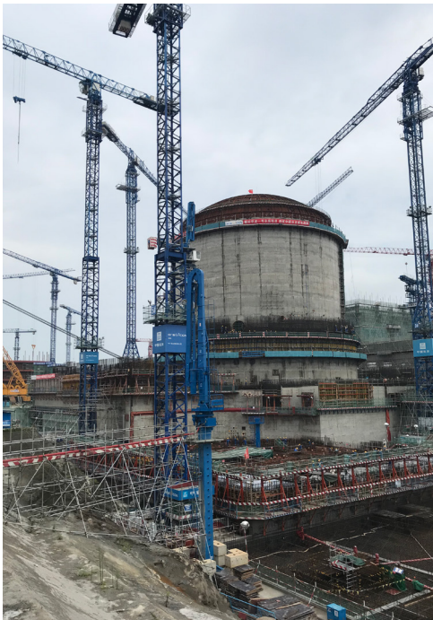
Fangchenggang 3&4, China 2018-ongoing
