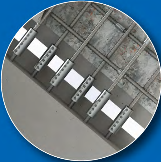
Juntas de construcción
