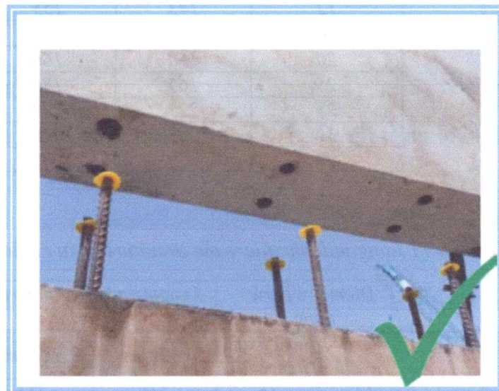
Fig. 7 Poziția corectă a discurilor de etanșare în aplicații verticale de asamblare prin injecție
